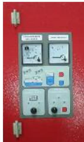
En equipo de más de una bomba principal, aconsejamos la utilización de un cuadro por cada bomba principal. Cuadros construidos según NORMAS 23-500-90, incorporan todas las señalizaciones, alarmas y características técnicas reflejadas en la norma.
